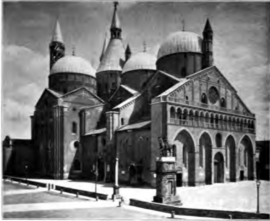
Vue extérieure de la Basilique de Saint-Antoine.
